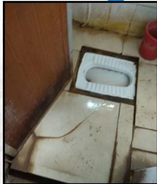
Ladies Toilet, GPO Patna
